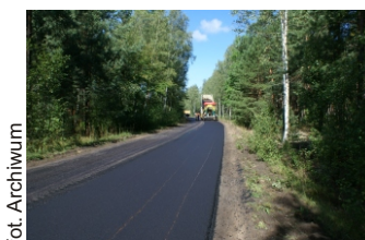
Nowy asfalt na drodze Kadzidło-Piasecznia
