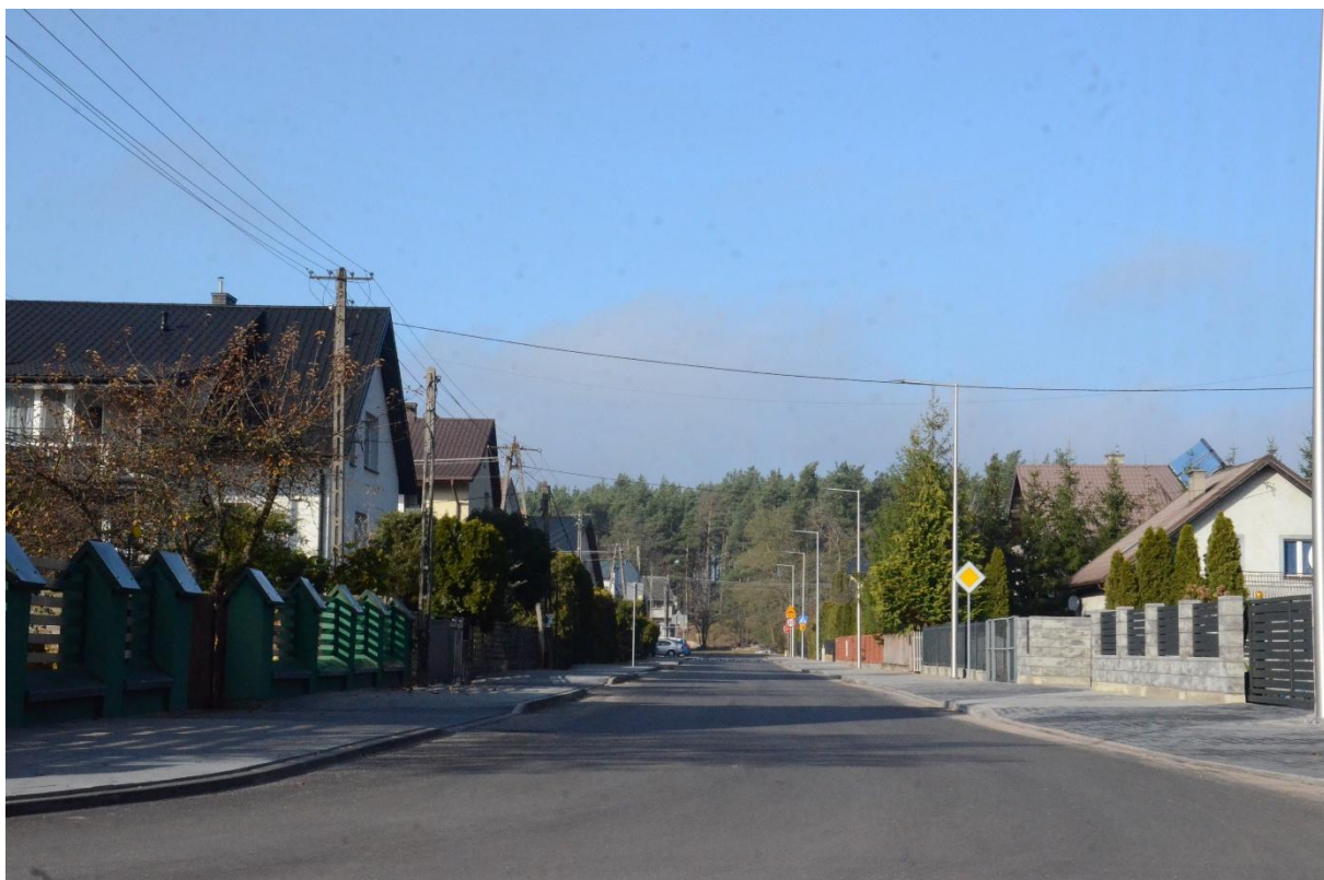
Na to zadanie gmina pozyskała dofinansowanie z Rządowego Funduszu Rozwoju Dróg
