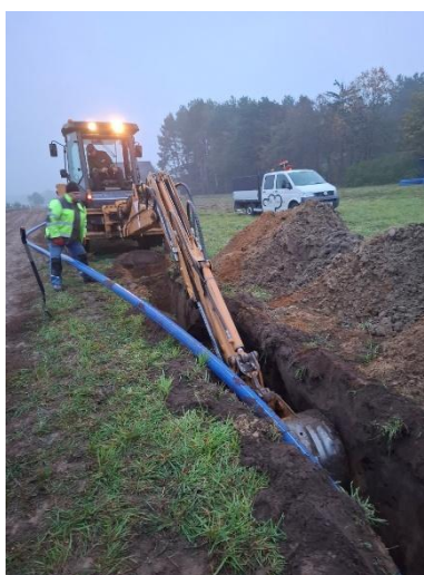
Wodociąg w Strzałkach, na zlecenie Gminy, wykonał Zakład Gospodarki Komunalnej i Mieszkaniowej w Kadzidle
