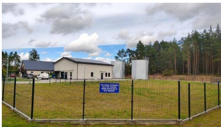
Stacja Uzdatniania Wody w Jazgarce
